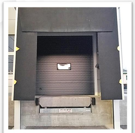
Soluzione con rampa in Acciaio INOX
