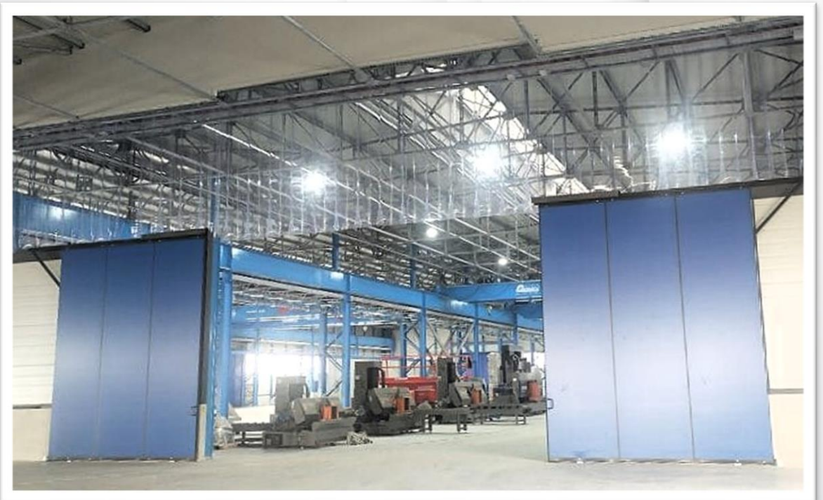
Soluzione speciale per passaggio carroponte
