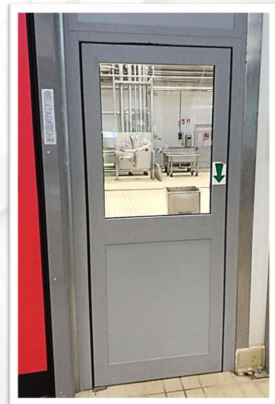
Soluzione con meccanismo «va e vieni»
